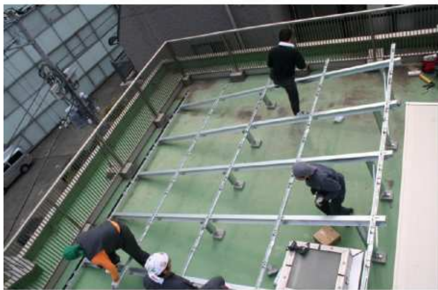
モジュール架台設置基礎工事
