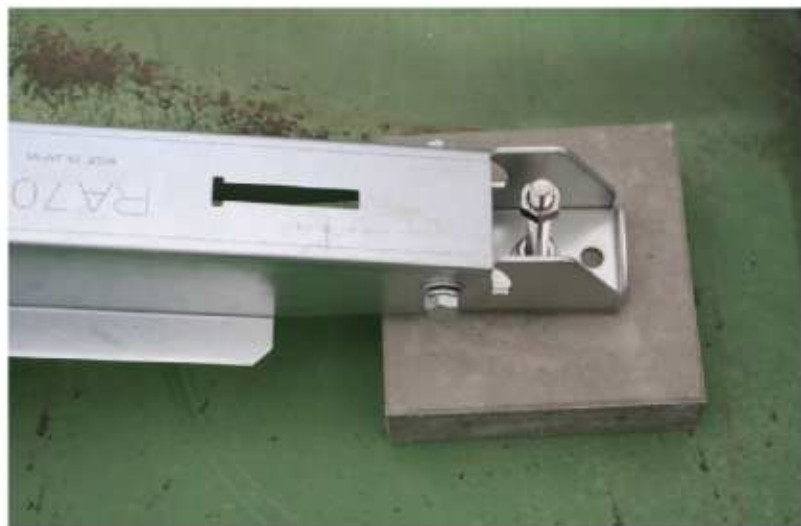
モジュール架台設置基礎工事
