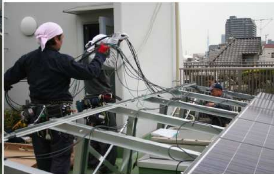
モジュール配線工事
