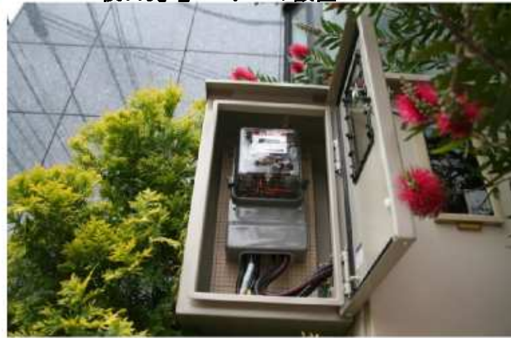
後日売電メーターの設置
