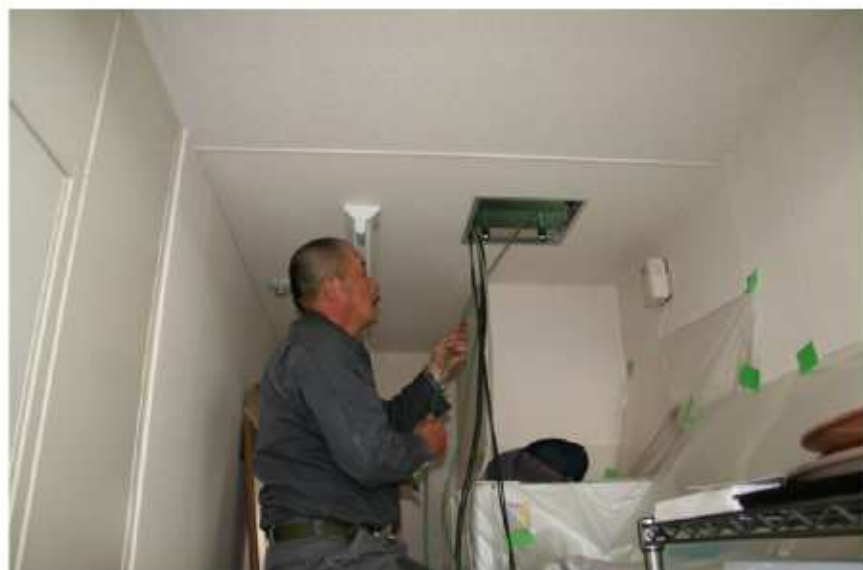
電気配線工事
