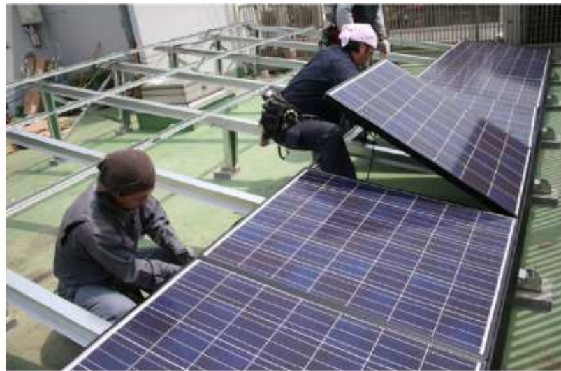
モジュール設置工事
